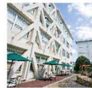
耐震化された校舎
